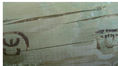
**Rissbildung:** Durch die Aufnahme und die Abgabe von Feuchtigkeit bilden sich in Holzbauteilen Spannungen. Speziell bei der Trocknung entstehen so genannte radiale Schwundrisse.
